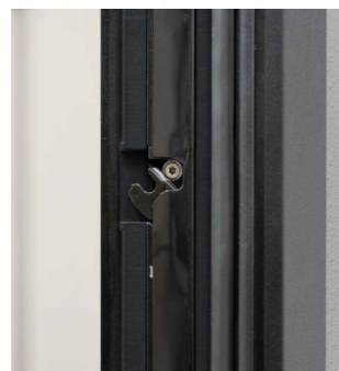
Der Verschluss mit pferdekopfförmiger Verriegelung im Rahmen
